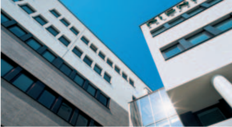
Edificios de oficinas Drienerbeek, NL-Enschede Arquitecto: I/AA Architekten & Ingenieures, NL-Enschede StoVentec con piedra natural
