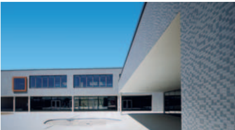
Escuela primaria de Erding, D-Erding Estudio de arquitectura: Architekten Dinkel, Persch / Stefan Dinkel, D-Munich StoVentec con cerámica
